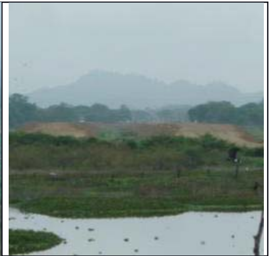
Fin del canal de desagüe
