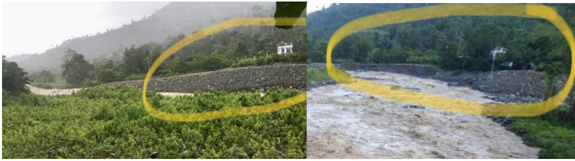
Casa de máquinas de Hidrotambo protegido por muro de piedras 01 de marzo, 2020
